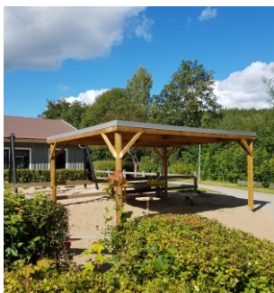
Solskydd Flässjum 4:174 (foto taget vid platsbesök 2020-09-01)
