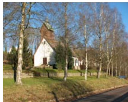
Olsfors kyrka, byggd 1916.
