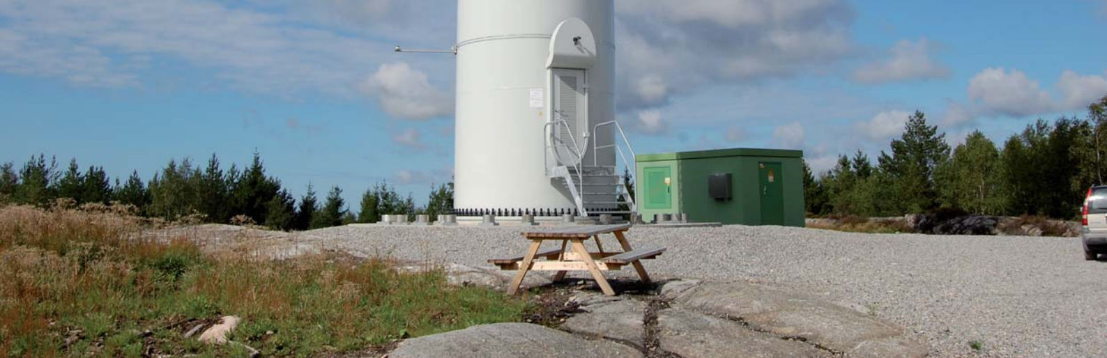
Fundament och transformatorstation tillhörande ett vindkraftverk vid Huds moar, Tanums kommun
