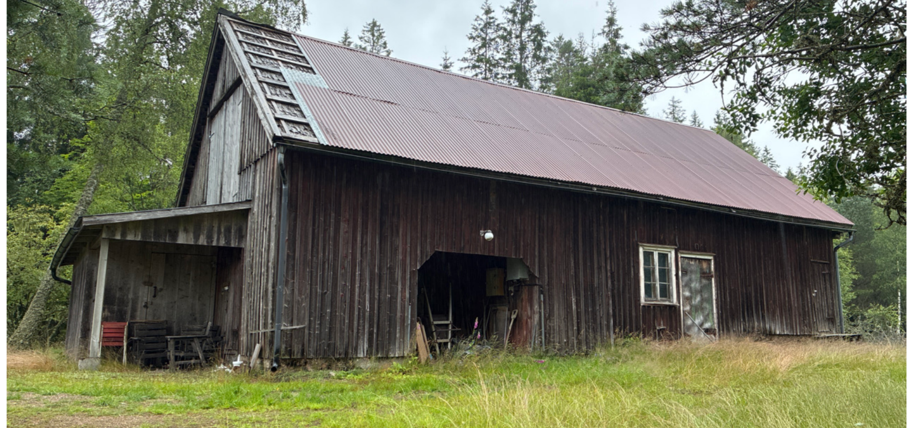
Figur 35: Exempel på ekonomibyggnad med entrén indragen i fasadlivet, i regionen vanligtvis kallad skonke, utskott eller skullutskott.
