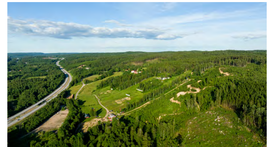
Figur 19: Vy över väg 40, skid- och cykelanläggningen Bollekollen och Hunarets dalsida samt skogarna i den östra delen av järnvägskorridoren.
