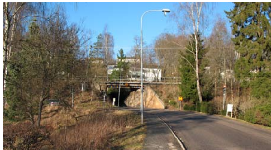
Vägporten under järnvägen i Olsfors.
