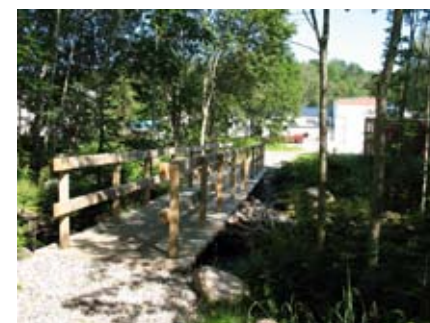
En nyligen färdigställd gångbro över Sörån i centrala Olsfors.
