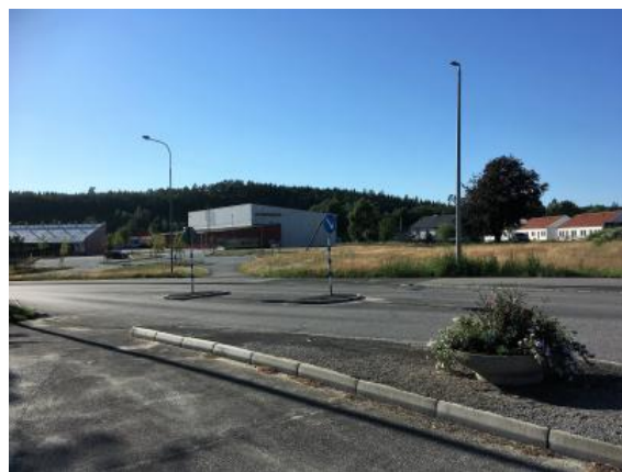
Vy över ny övergång med refug till Hyssnaskolan och nya idrottshallen. Till höger i bild skymtar den nya bebyggelsen norr om skolan.
