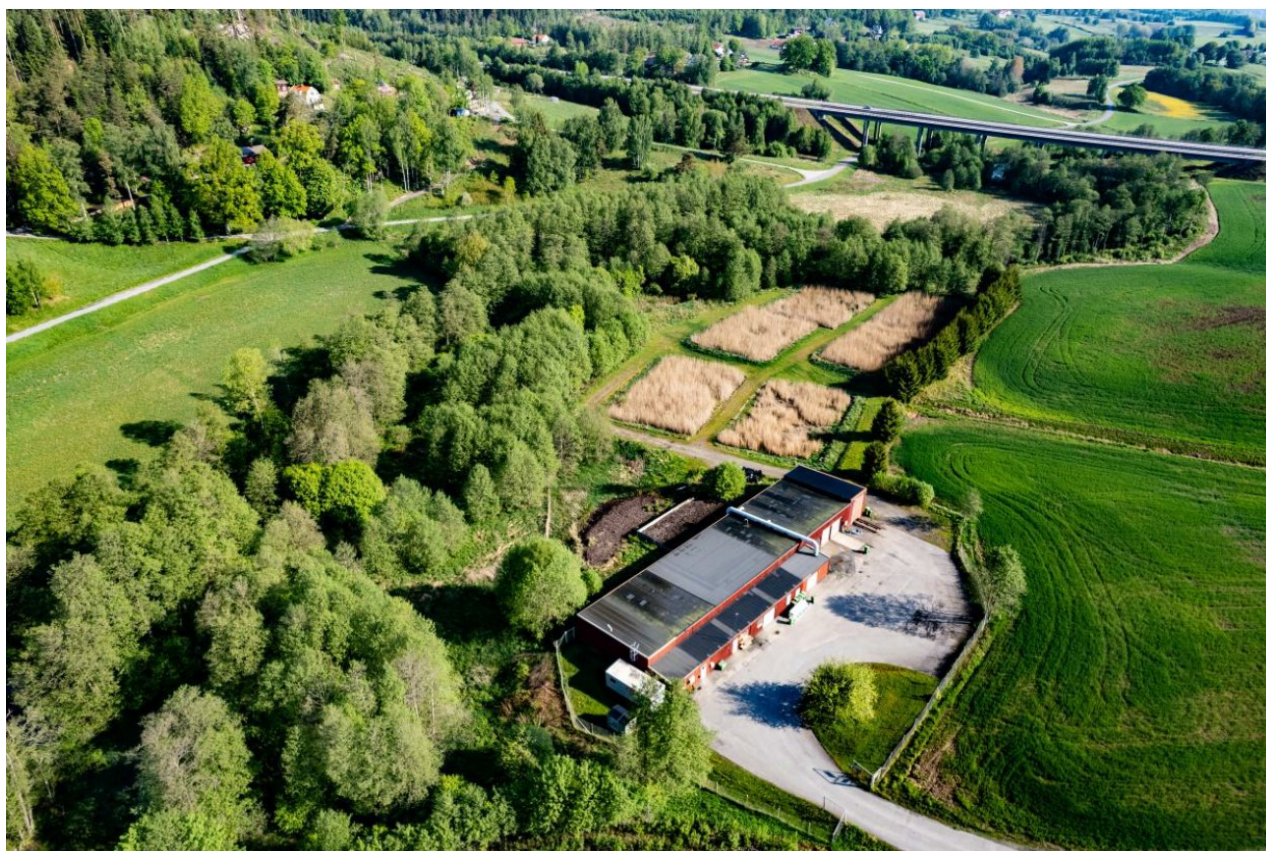
Figur 11. Drönbild tagen 2023-05-24, från recipientutredningen (Bilaga 2). Reningsverkets byggnad och vassbäddarna för slamhantering syns i bilden, liksom riksväg 40 på bro i bakgrunden. Nollan går till vänster om reningsverket, men är dold bakom träd.
