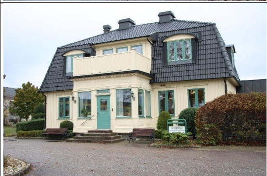
Flässjum 4:92, f.d. mangårdsbyggnad tillhörande ett av byn Flässjums äldre gårdslägen
