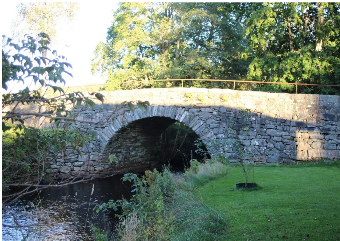
Figur 51 Stenvalvsbro över Nolån. Bollebygds Prästgård S:1.
