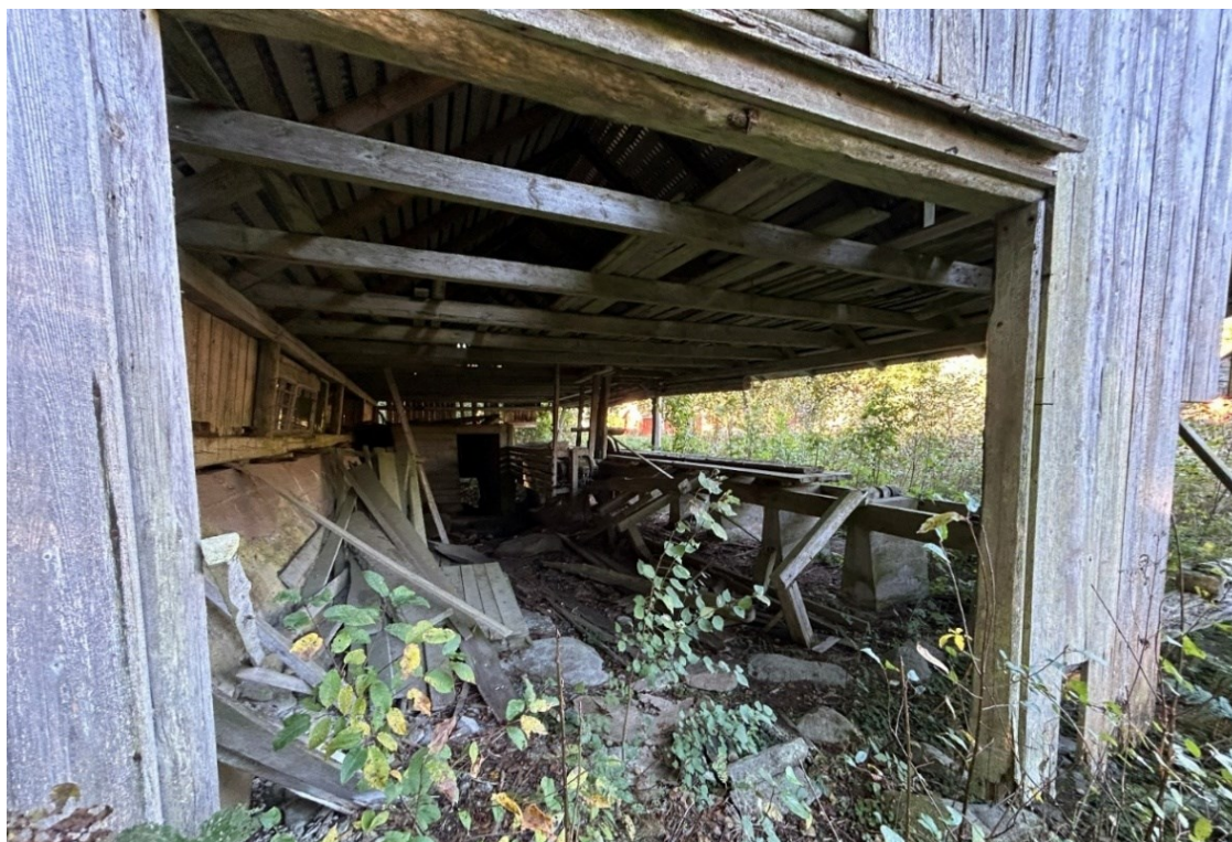
Figur 20 Sågverksbyggnaden vid Sörån. Torstad 1:17.
