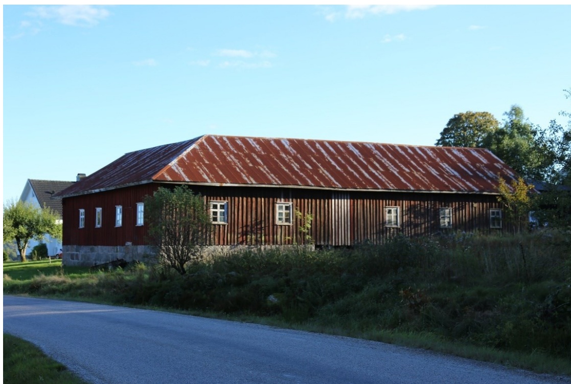
Figur 47 Ekonomibyggnad i Stenaskjum
