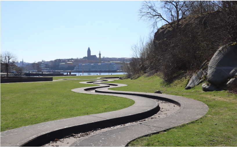
När det regnar blir vattenstråket synligt och leder dagvattnet genom parken, samtidigt som det skapar en lekfull miljö för att följa, utforska och leka med vattnet. Lindholmen, Göteborg.
