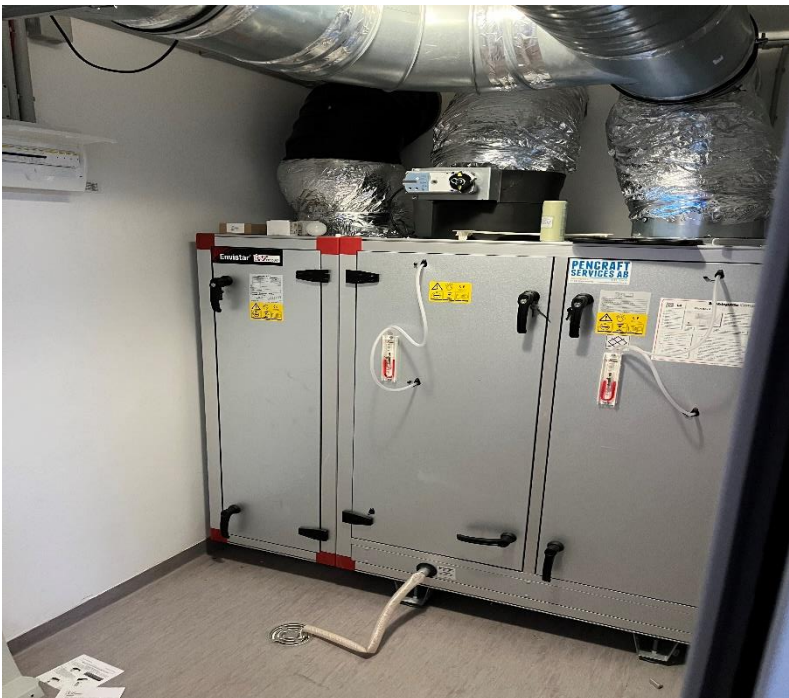
Rum 10 Teknik: Löst material, skräp ligger på aggregaten
