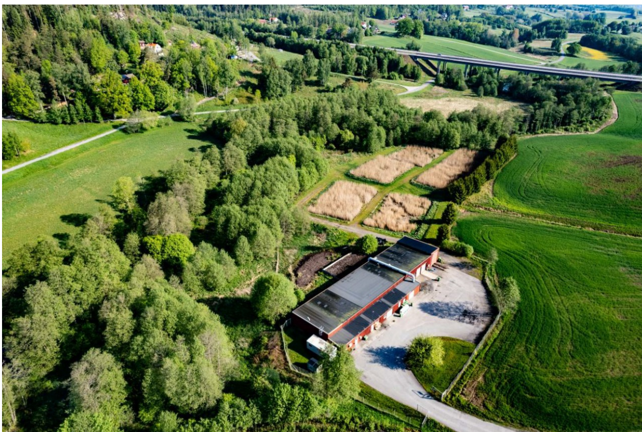
Figur 11. Drönbild tagen 2023-05-24, från recipientutredningen (Bilaga 2). Reningsverkets byggnad och vassbäddarna för slamhantering syns i bilden, liksom riksväg 40 på bro i bakgrunden. Nolån går till vänster om reningsverket, men är dold bakom träd.
