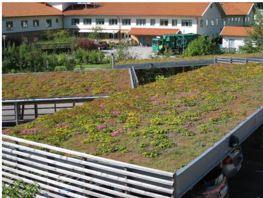
Figur 24. Exempel på grönt tak över garagebyggnad, Kungsbacka. Bildkälla: VegTech AB.
