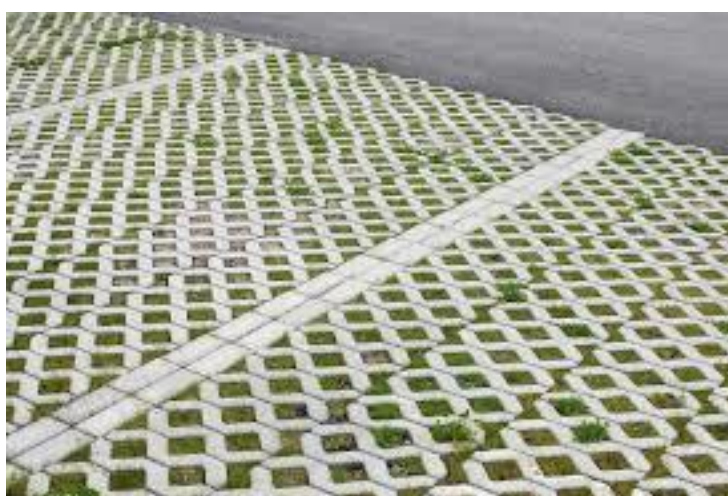
Figur 22. Exempel på permeabel parkeringsyta. Foto: Marie Larsson, Sweco.
