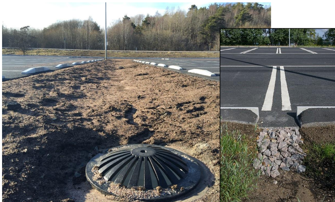
Figur 30. Exempel på nylagd översilningsyta från parkeringsplats. Gräset är inte uppväxt ännu.
