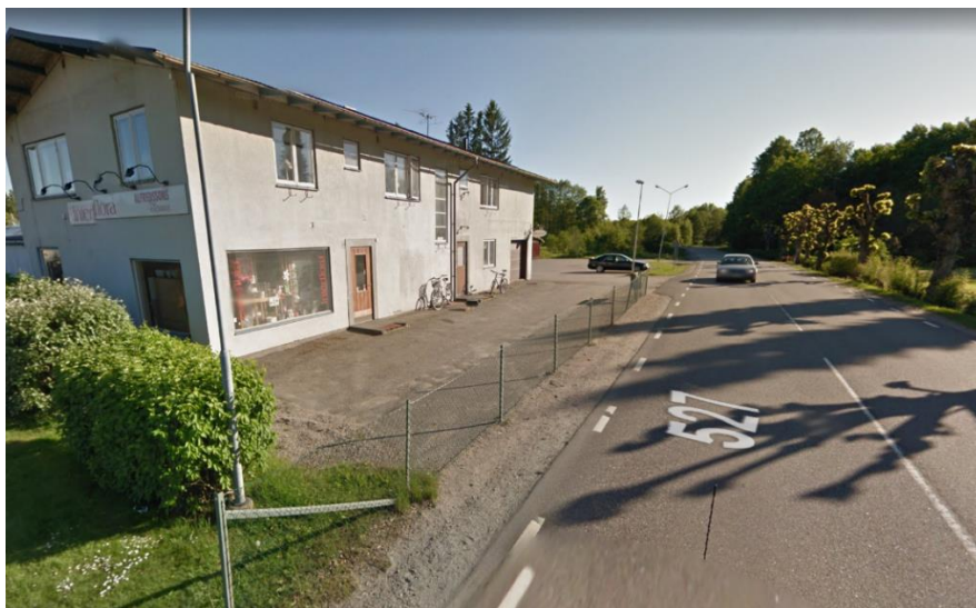
Figur 7. Rävlandavägen sett från andra hållet. Byggnad ligger nära vägen. Bildkälla: Googlemaps
