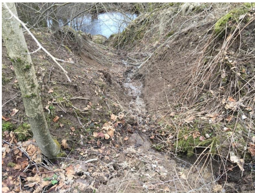
Figur 17. Dike ned mot Sörån.
