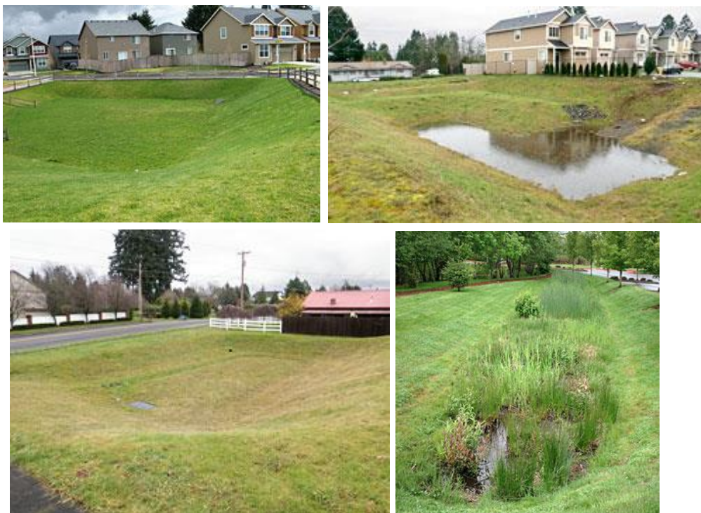
Figur 28. Exempel på utformning av fördröjningsytor. Bildkälla: www.stormwaterpartners.com
