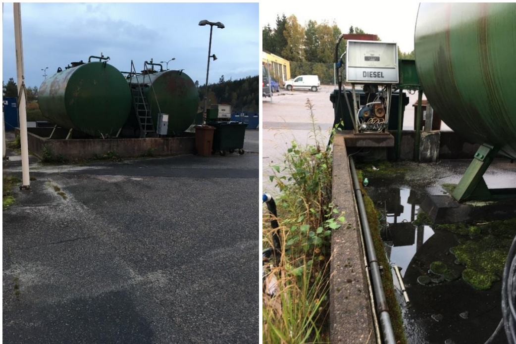
Betonginvallning för dieselcisterner.
