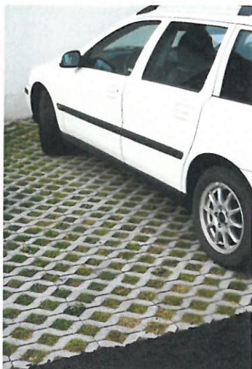
Bild 11. Gräsarmering till parkeringsytor (S:t Eriks)
