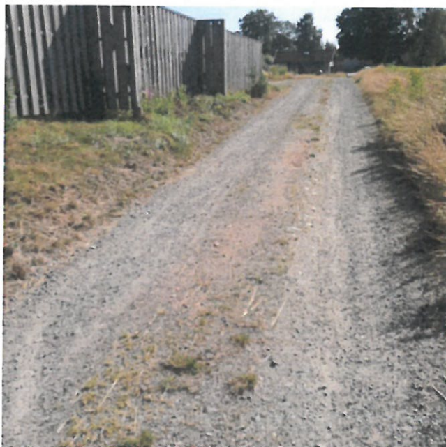
Bild 2 Befintlig grusväg (Foto J. Kuzele)
