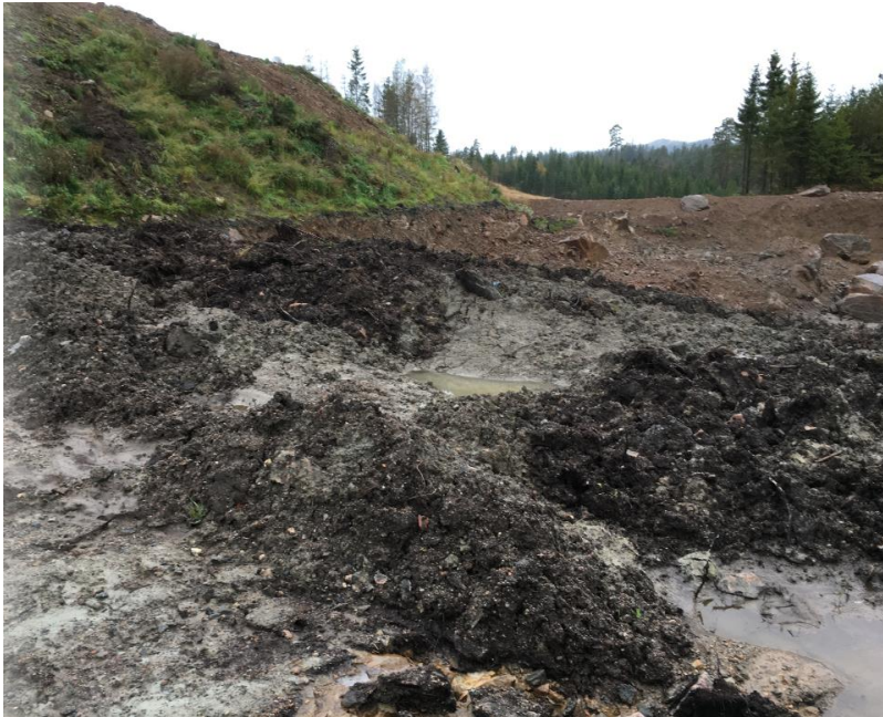
Bild 12 Vy mot motorvägen från nivå 1
