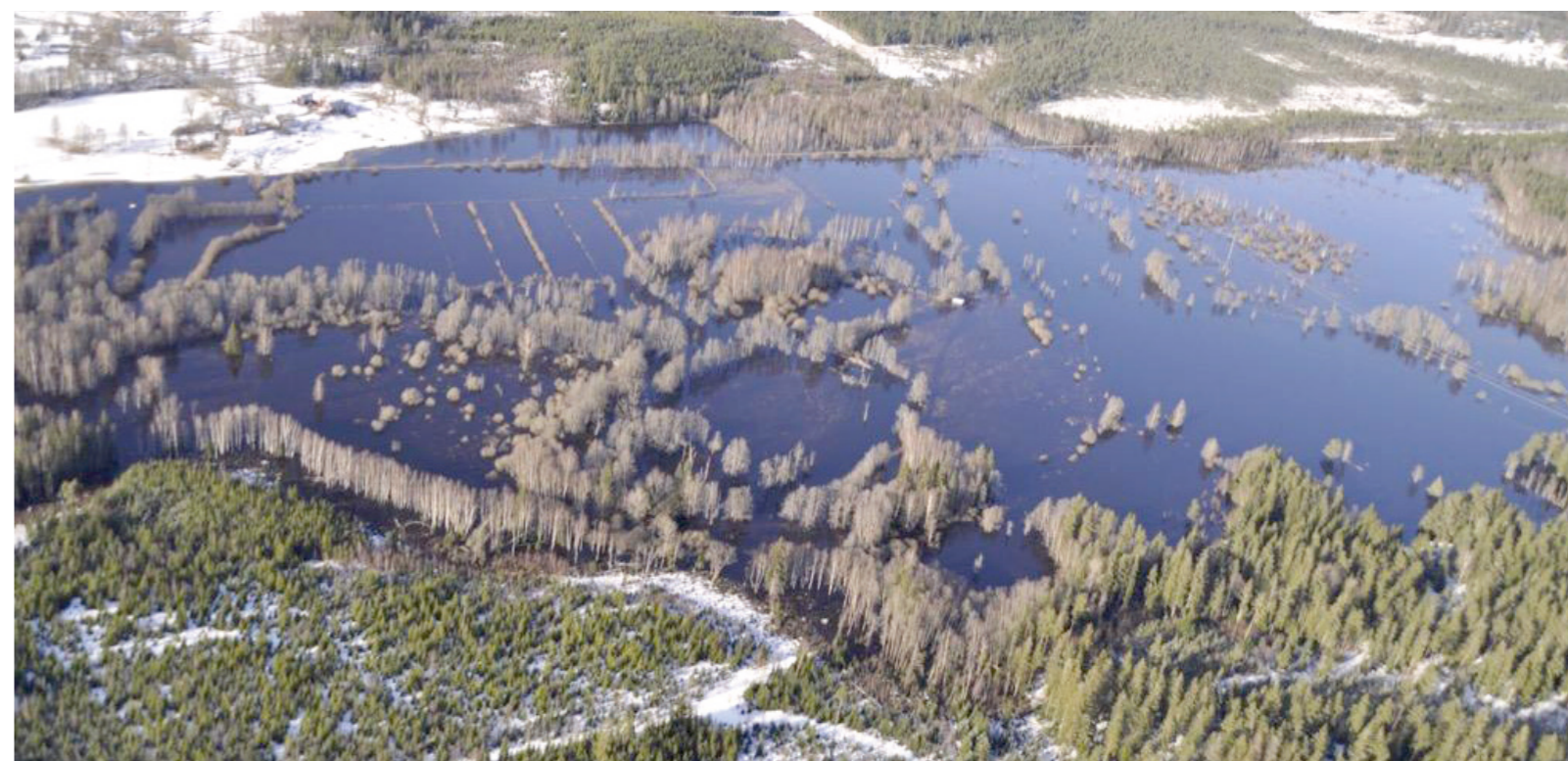
Flygfoto över centrala Svenljunga med stenbron samt översvämmad åkermark längs Ätran. Fotograf: Frivilliga Flygkåren
