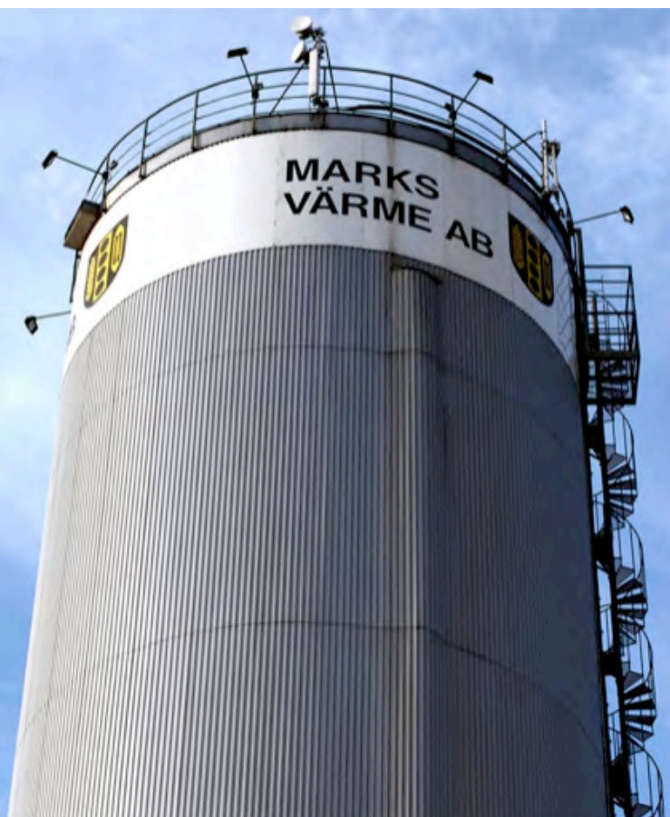
Figur 8:43. Marks fjärrvärmeverk i Assberg.
