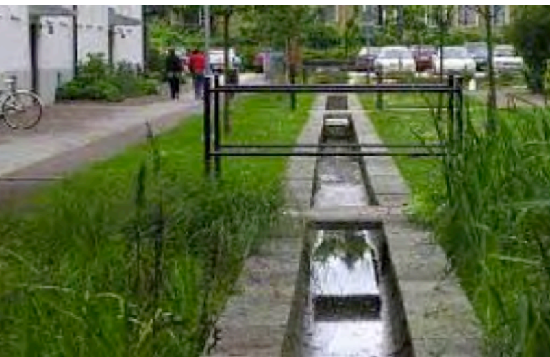
Figur 8:25. Exempel på öppna dagvattenlösningar, se kapitel 7.2 Klimatrisker . Källa: Klimatanpassningsportalen, klimatanpassning.se
