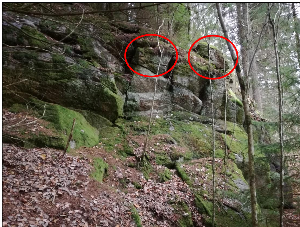
Figur 2: Bergslänten ligger ca 10 innanför skogskränet som ansluter till detaljplansområdet. Stabiliteten i skärningen anses allmänt god givet avståndet till planerad byggnation. Bergrensning rekommenderas för block markerade med röd cirkel i bilden.
