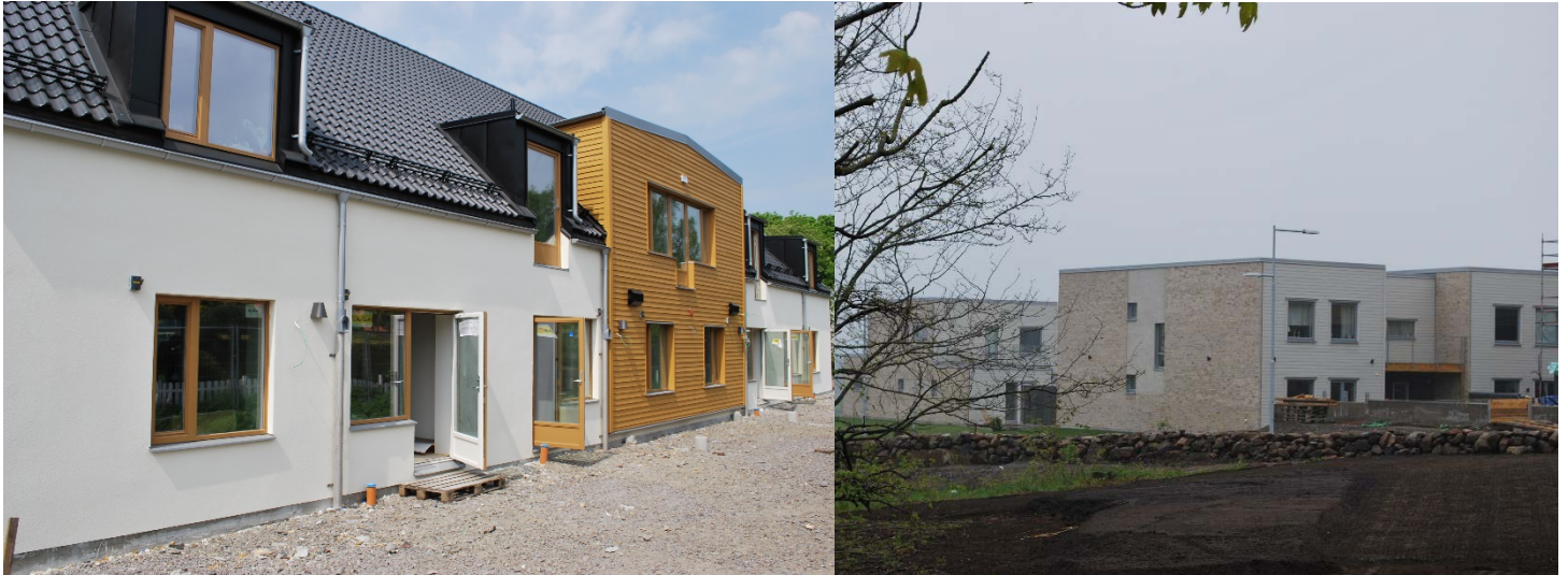
Exempel vänstra bilden, på villor/parhus, Emrabus, Helsingborg, Exempel högra bilden, parhus Varbergs kommun.
