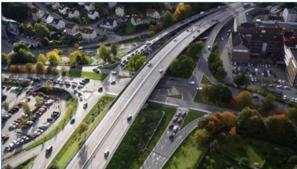
Figur 7-2 Översikt Annelundsmotet, tisdagen 4 oktober mellan kl. 16 och 17 (Källa: Sweco).
