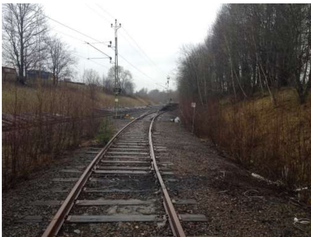
Figur 5-13 Industrispåret till Stora Ensos anläggning i Assberg ligger kvar men har berövats sin anslutningsväxel. Återupptagande av godstrafiken, vilket diskuterades under 2014 ställer krav på återinläggning av industrispårväxeln samt att industrispåret rustas upp.
