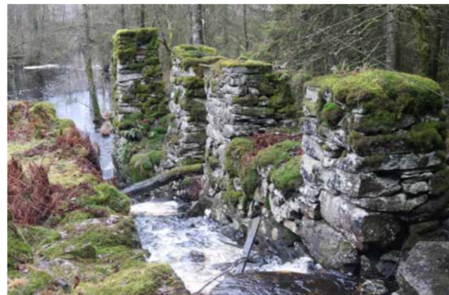
Figur 5.17 Lämningar efter Katrinefors kopparhammare. Foto: KMV forum.
