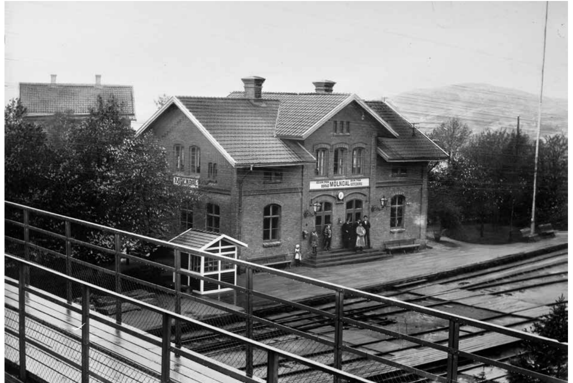
Figur 1.1 Stationsbyggnaden vid Mölndals övre, cirka 1940. Foto: Järnvägsmuseet (Public domain/Utgången upphovsrätt)
