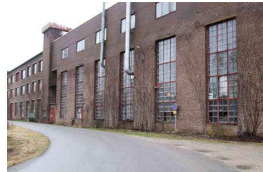
Figur 5.18 Industribyggnader vid Rydboholms fabriker. Foto: KMV forum.
