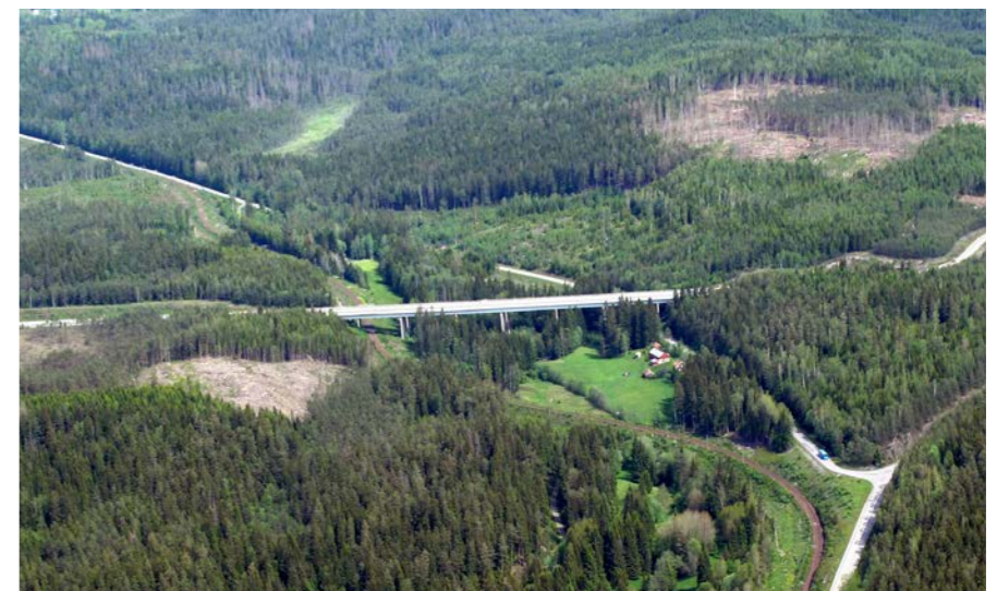
Figur 4.15 Bilden visar väg 27/40 på bro över Grandalen med Kust til kustbanan och Rävlandavägen. Ett större viltstråk går i nordsydlig riktning. (Foto: E-matic, 2015)
