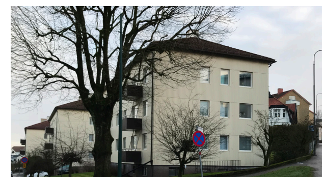
Figur 7.61 Friliggande lamellhus i Salängen.
