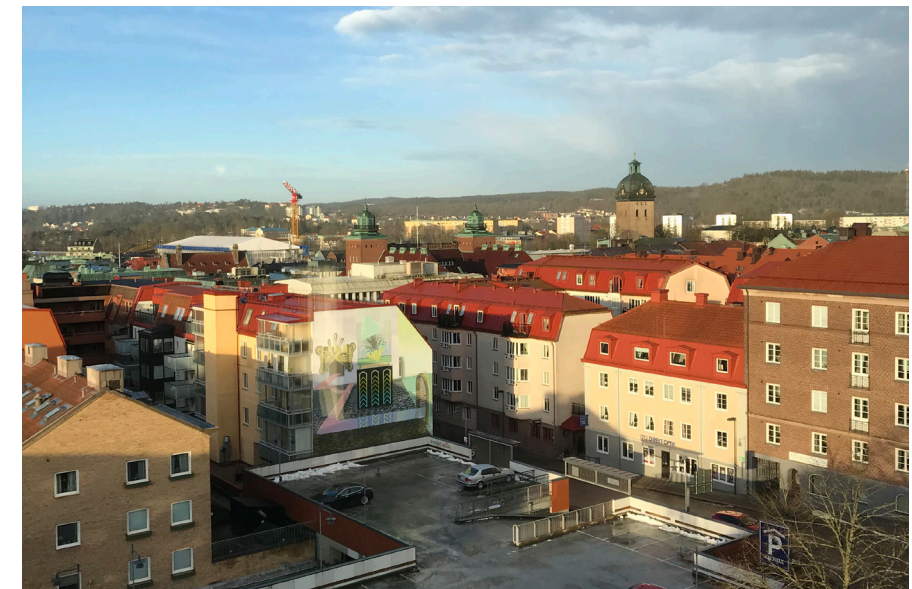
Figur 7.52 Del av Borås centrum. Vy mot nordväst.
