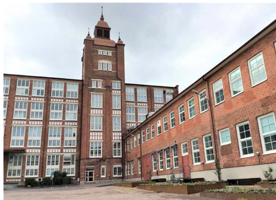
Figur 7.22 Krokslätts fabrikers gamla tegelbyggnader med utsmyckad fasad.
