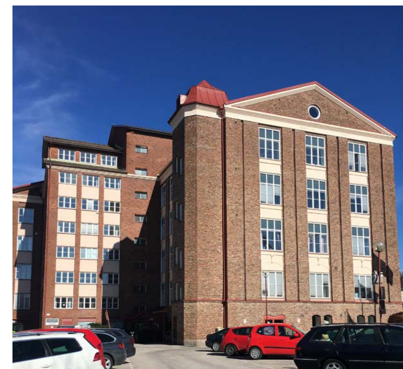
Figur 7.58 Äldre industribebyggelse utmed Viskan.
