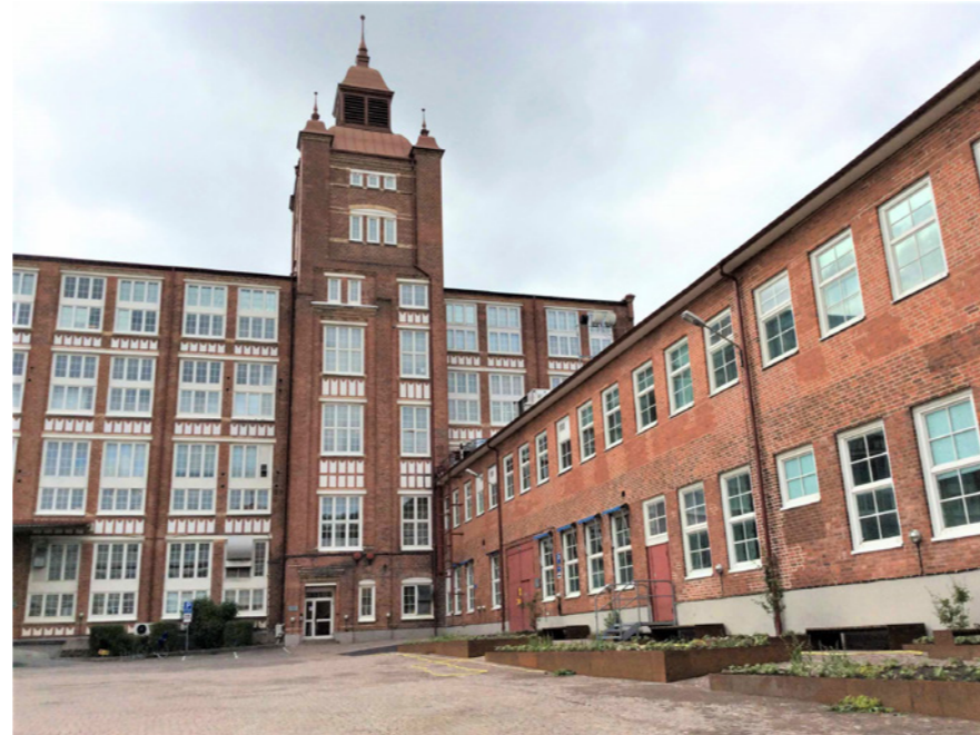
Figur 4.9 Krokslätts fabrikers gamla tegelbyggnader med utsmyckad fasad.
