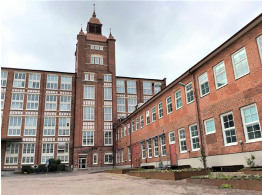
Figur 4.10 Krokslätts fabrikers gamla tegelbyggnader med utsmyckad fasad.
