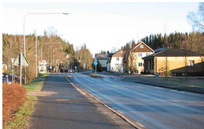
Boråsvägen, väg 1757, byggdes om för några år sedan.
