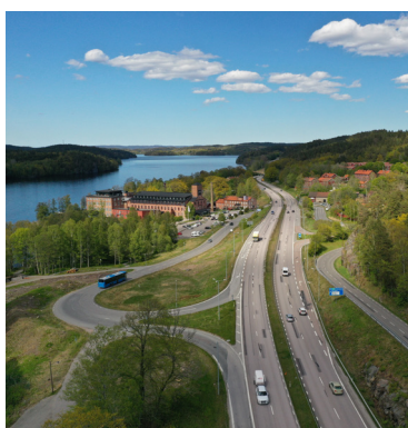
Väg E20 i Tollerred
