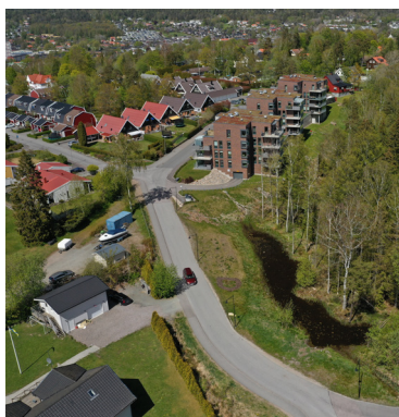
Dagvattendamm vid Bygrindsvägen
