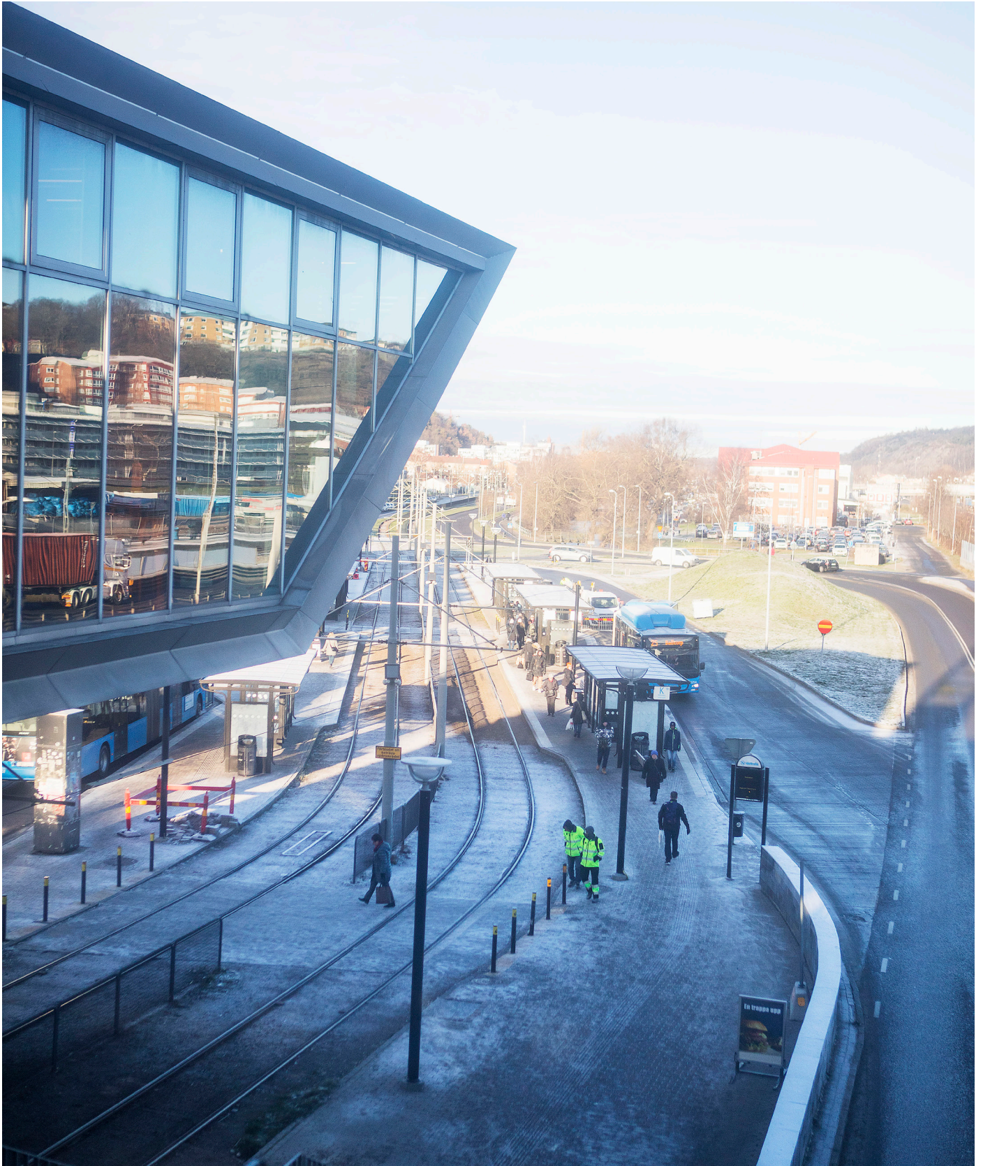
Mölndals resecentrum är redan idag en av de viktigaste knutpunkterna i Göteborgsregionen. Med en station på den nya stambanan mellan Göteborg-Stockholm kommer denna nod att stärkas ytterligare.
