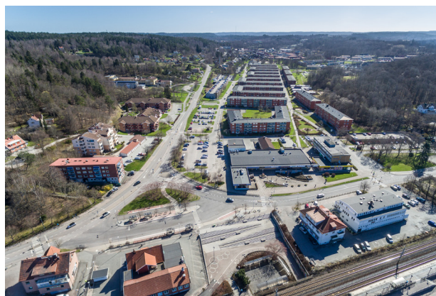
Källered omges av infrastruktur och höjder med grönska
