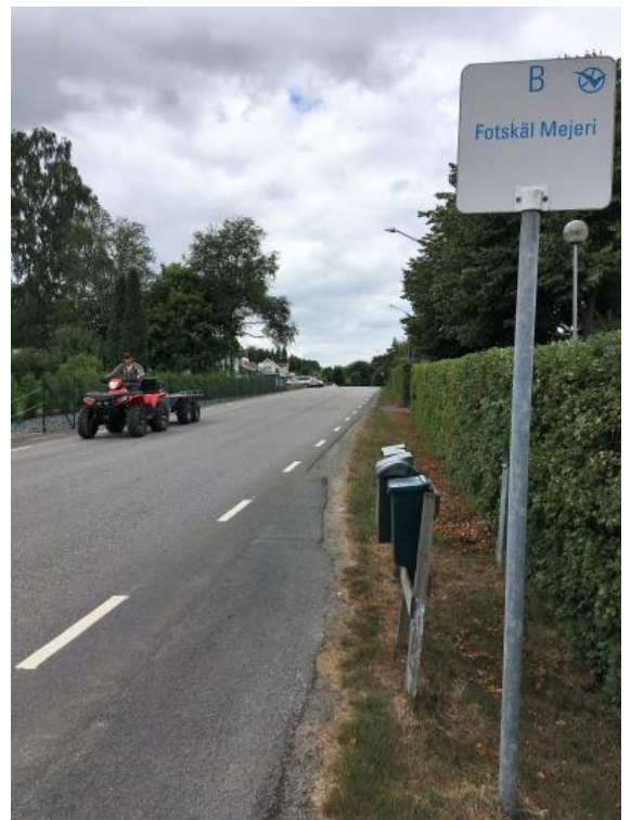
Den externa länken, väg 1602 (Tostaredsvägen)
