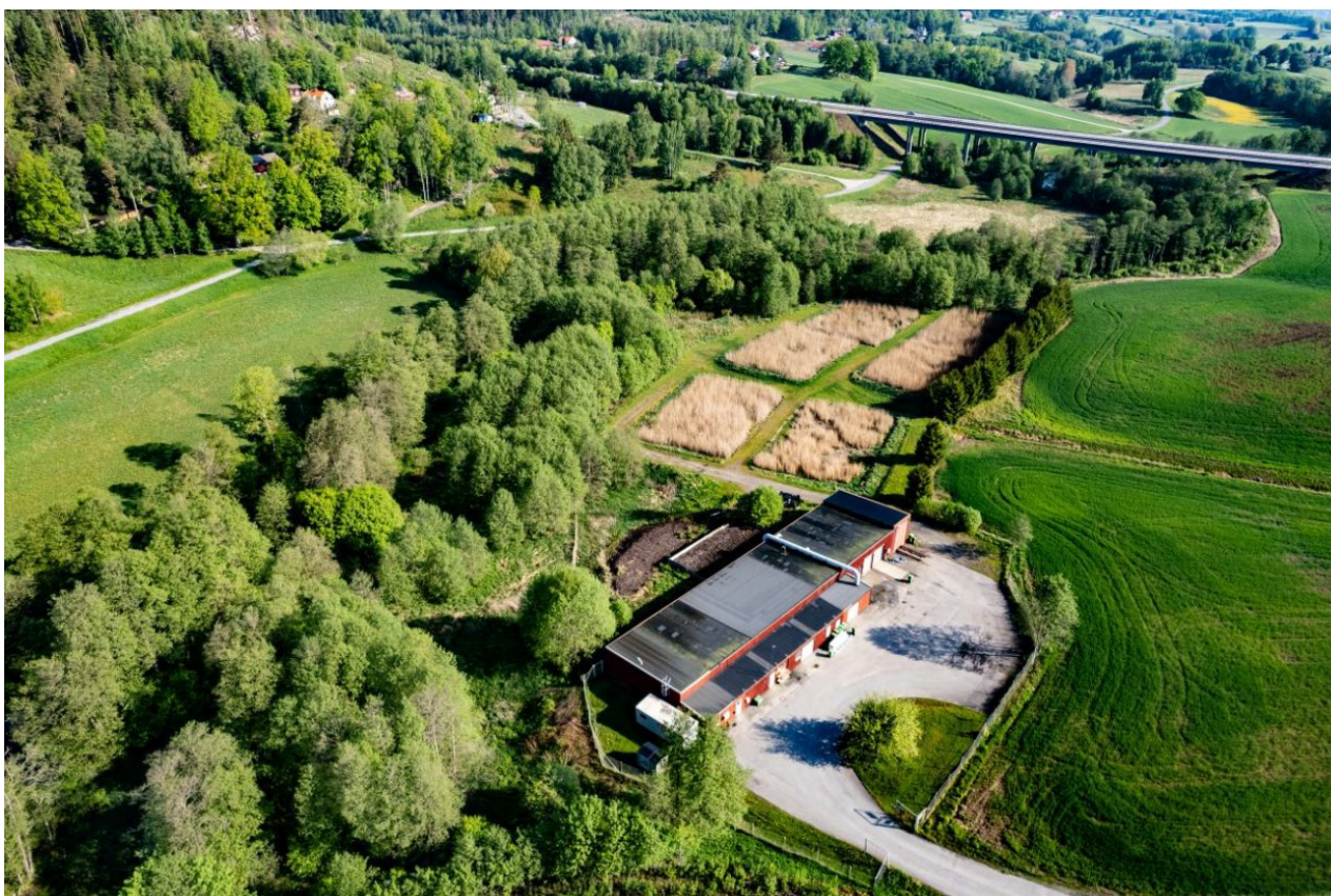
Figur 11. Drönbild tagen 2023-05-24, från recipientutredningen (Bilaga 2). Reningsverkets byggnad och vassbäddarna för slamhantering syns i bilden, liksom riksväg 40 på bro i bakgrunden. Nolån går till vänster om reningsverket, men är dold bakom träd.
