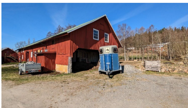
Stallbyggnad och gödselstack.
