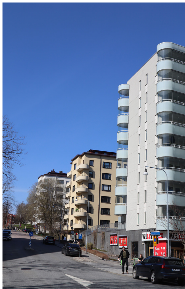
Exempel på ny byggnad förhåller sig till äldre byggnader i funktionell stil från Carlanderska sjukhuset, Göteborg. Arkitekt: White Arkitekter (2023)
