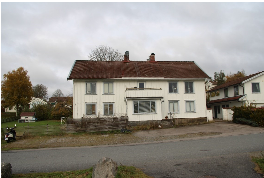
Figur 7 Mangårdsbyggnad till en av Flässjums äldre gårdar. Flässjum 12:75.
