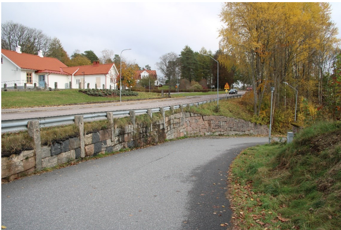
Figur 5 Terrängen i tätorten är bitvis mycket kuperad och höjdskillnaderna tas många gånger upp av äldre kallmurade stöd- eller terrasseringsmurar i sten, både på privata tomter och allmänna platser. Det f.d. Tingshuset på Flässjum 1:34 till vänster i bild.
